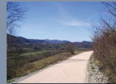
Sable stabilisé à liant hyperpouzzolanique
