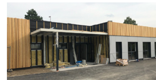
Second pôle de restauration
